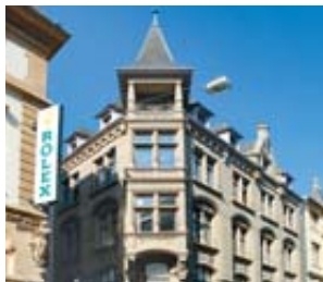
Freie Strasse 38, Basel
