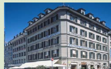
Bern, Zeughausgasse 26/28 rentable area: 3'469 m 2
