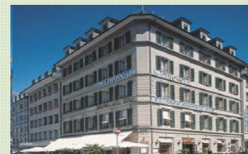
Bern, Zeughausgasse 26/28 rentable area: 3'476 m 2
