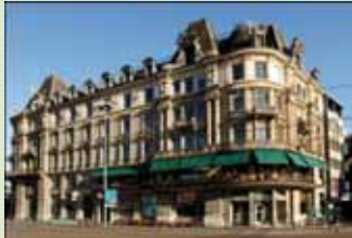
Zurich, Bahnhofplatz 1 rentable area: 2'077 m 2
