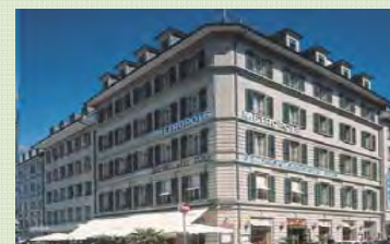
Bern, Zeughausgasse 26/28 rentable area: 3'476 m 2
