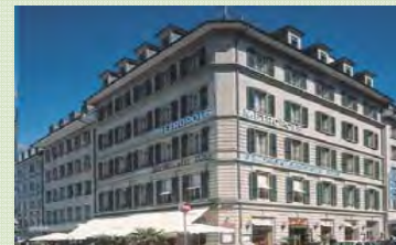
Bern, Zeughausgasse 26/28 rentable area: 3'476 m 2
