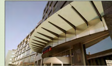
Fribourg, Rte des Arsenaux 41 rentable area: 11'304 m 2
