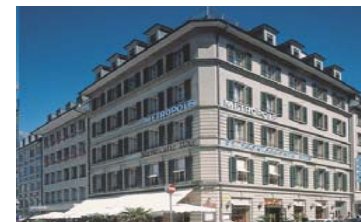
Bern, Zeughausgasse 26/28 rentable area: 3'476 m 2
