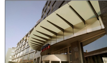
Fribourg, Rte des Arsenaux 41 rentable area: 10'754 m 2
