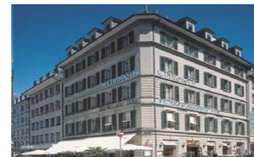
Bern, Zeughausgasse 26/28 rentable area: 3'476 m 2
