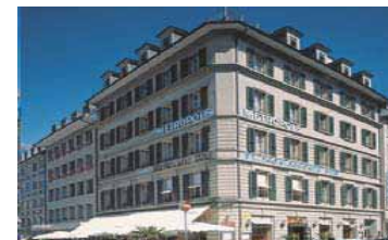
Bern, Zeughausgasse 26/28 rentable area: 3'476 m 2
