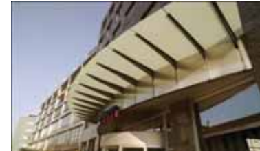
Fribourg, Rte des Arsenaux 41 rentable area: 10'763 m 2
