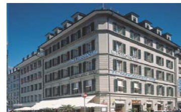
Bern, Zeughausgasse 26/28 rentable area: 3'459 m 2
