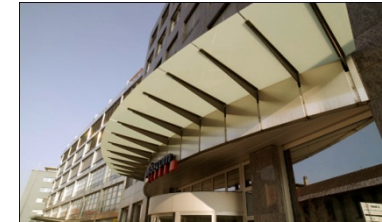
Fribourg, Rte des Arsenaux 41 rentable area: 10'776 m 2
