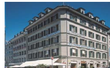
Bern, Zeughausgasse 26/28 rentable area: 3'459 m 2
