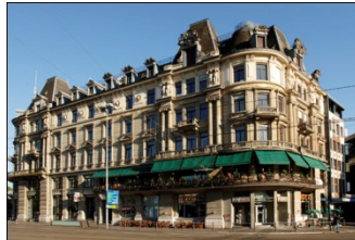
Zurich, Bahnhofplatz 1 rentable area: 2'095 m 2
