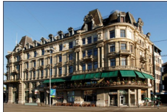
Zurich, Bahnhofplatz 1 rentable area: 2'095 m 2
