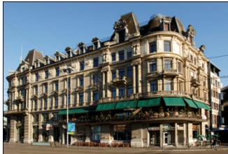
Zurich, Bahnhofplatz 1 rentable area: 2'095 m 2
