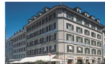
Bern, Zeughausgasse 26/28 rentable area: 3'451 m 2
