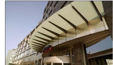
Fribourg, Rte des Arsenaux 41 rentable area: 10'873 m 2
