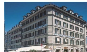
Bern, Zeughausgasse 26/28 rentable area: 3'451 m 2
