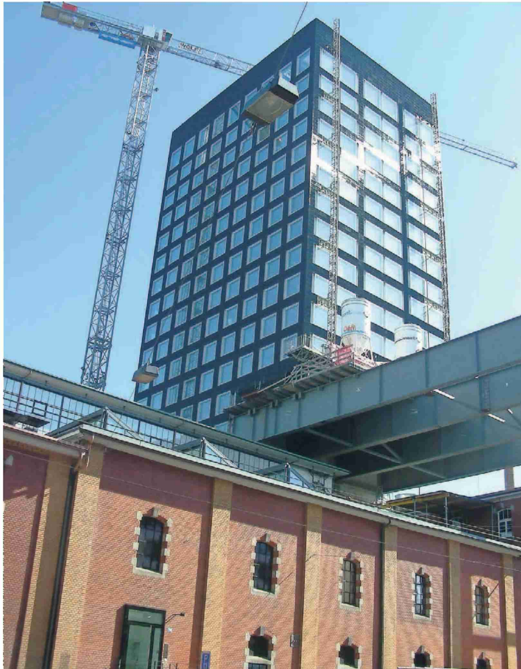
Der Löwenbräu-Turm wird nun mehr wegen seines markanten Äusseren als seiner Schiefelage bestaunt. AER
