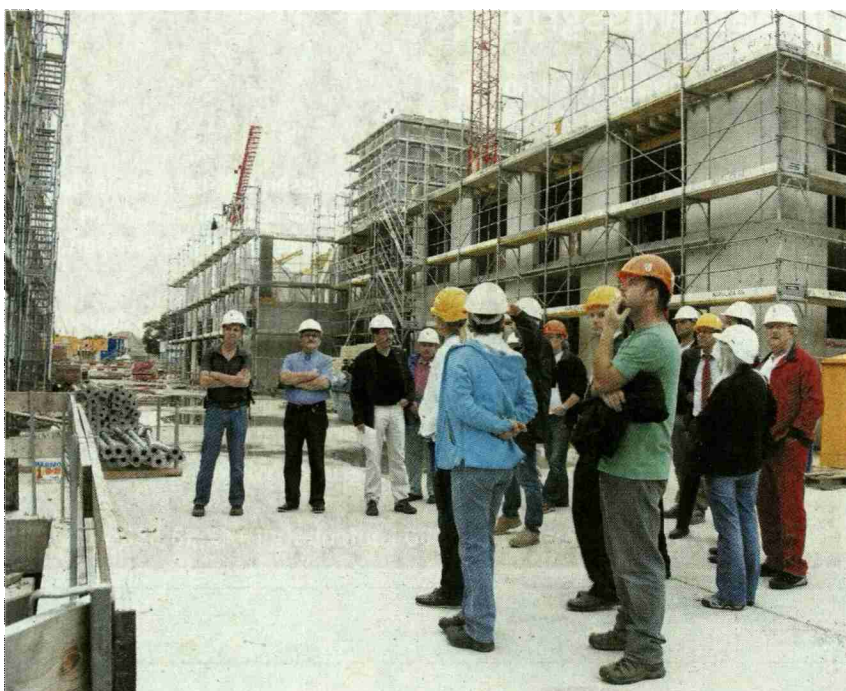
Hier entsteht ein neuer Stadtteil: Die Gewerbler besuchten die Grossbaustelle.
