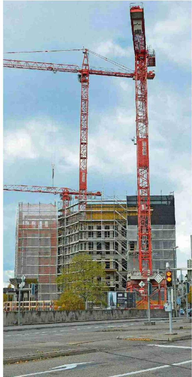
Der Grosspeter-Tower soll im Endausbau 78 Meter hoch werden und 22 Stockwerke haben. Im Sockel befindet sich das Ibis-Hotel mit 186 Zimmern. Das Foto rechts zeigt, dass fünf Geschosse bereits fertiggestellt sind. Mit dem Bau wurde vor einem Jahr begonnen.
