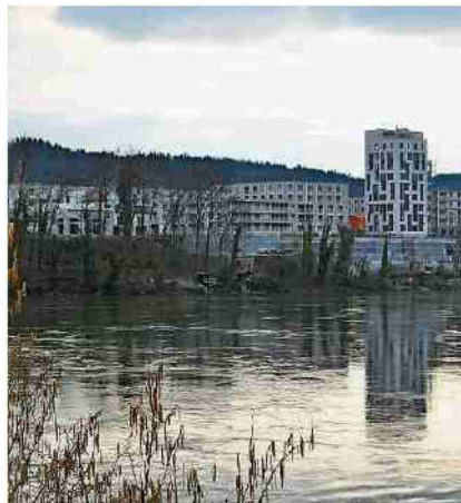
Westlich der Überbauung Salmenpark sollen vier Gebäude folgen. NBO
