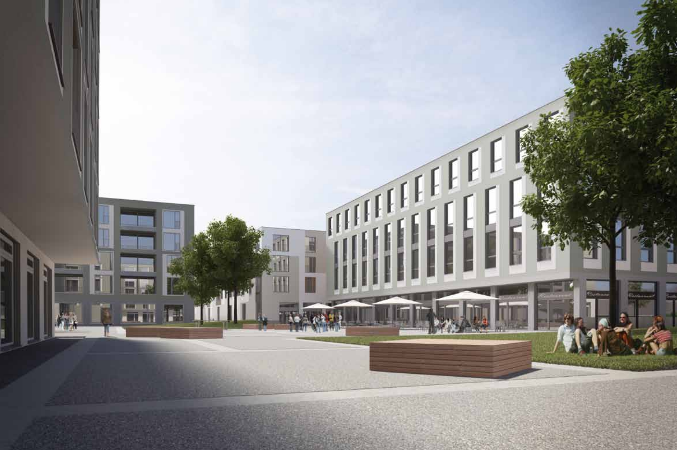
Im Osten des Platzhauses erstreckt sich der weitläufige Salmenplatz
